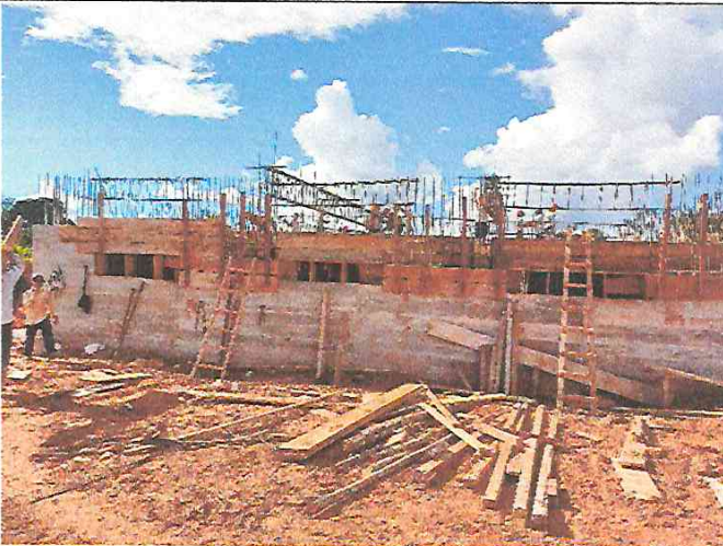
FOTO 08: COLOCACIÓN DE ACERO EN VIGAS DEL CENTRO CULTURAL
