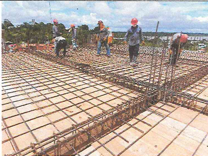
FOTO 11: COLOCACION DE ACERO EN LOSA MACIZA Y VIGAS DEL CENTRO CULTURAL SEGUNDO NIVEL
