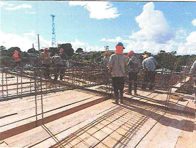
FOTO 09: COLOCACIÓN DE ACERO EN VIGAS DEL CENTRO CULTURAL
