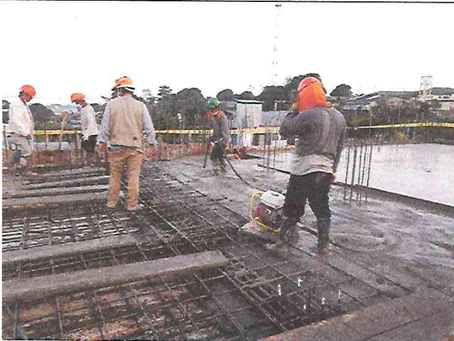
FOTO 17: VACEO DE LOSA MACIZA, LOSA ALIGERADA, NERVADA F'C=210 KG/CM2 DEL CENTRO CULTURAL SEGUNDO NIVEL
