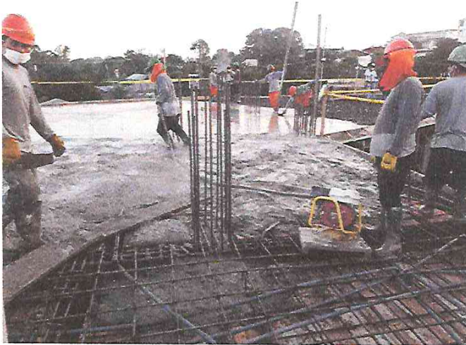
FOTO 16: VACEO DE LOSA MACIZA, LOSA ALIGERADA, NERVADA F'C=210 KG/CM2 DEL CENTRO CULTURAL SEGUNDO NIVEL
