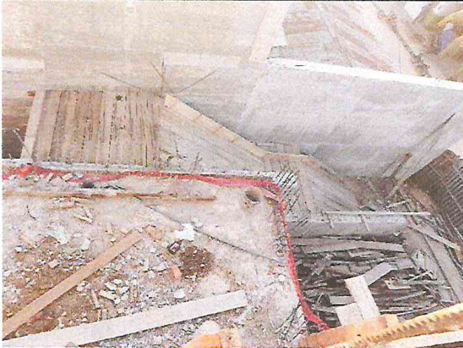
FOTO 20: ENCOFRADO DE ESCALERA DEL CENTRO CULTURAL
