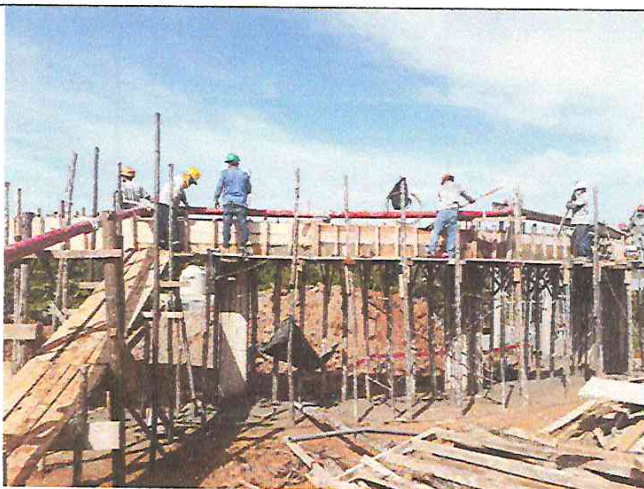
FOTO 23: VACEO DE VIGAS MORTERO F'C=210KG/CM2 DEL SKATE PARK 02
