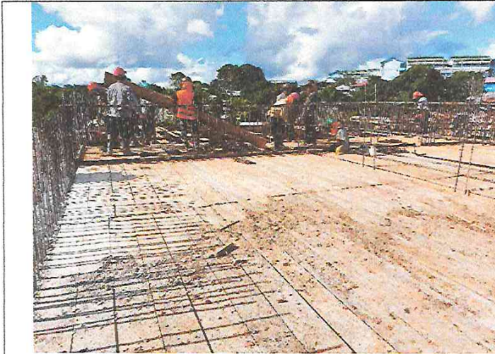
FOTO 10: COLOCACIÓN DE ACERO EN VIGAS DEL CENTRO CULTURAL
