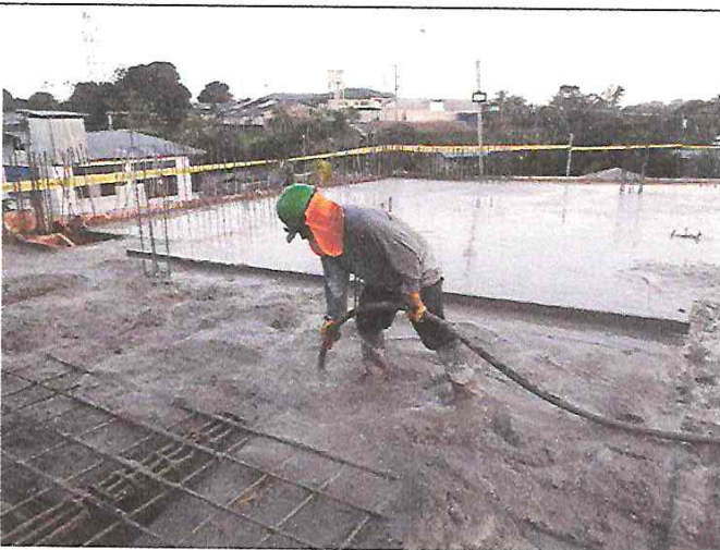
FOTO 18: VACEO DE LOSA MACIZA, LOSA ALIGERADA, NERVADA F'C=210 KG/CM2 DEL CENTRO CULTURAL SEGUNDO NIVEL
