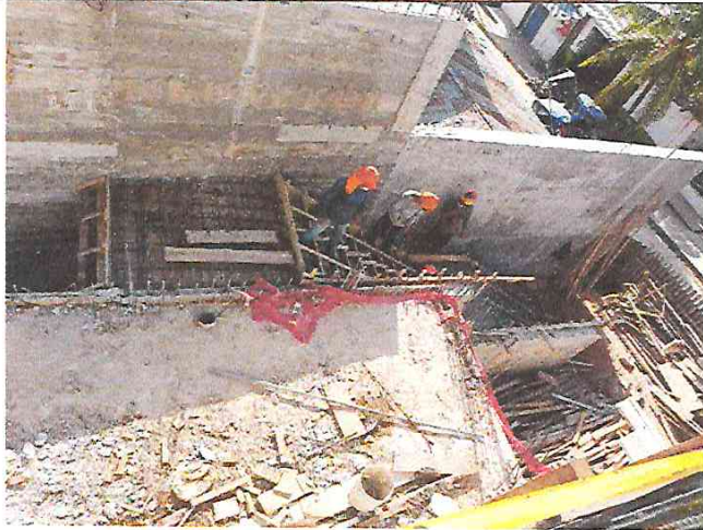
FOTO 22: VACEO DE ESCALERA MORTERO F'C=210KG/CM2 DEL CENTRO CULTURAL
